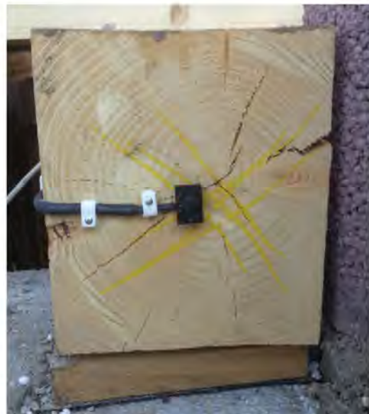
Abb. 9 Einbausituation des neuen Holzbalkenkopfes – Die warme Luft aus der Hypokaustenheizung sorgt für höhere Temperaturen und geringere Luftfeuchtigkeit am Balkenkopf. Sensoren geben stündlich Auskunft über die klimatischen Bedingungen in diesem Bereich.
