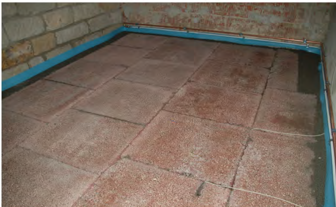
Abb. 5 Fußbodendämmung im nichtunterkellerten Gebäudeteil – Durch die haufwerksporigen Bodenplatten aus Blähton kann das Wasser schnell wieder abfließen.
