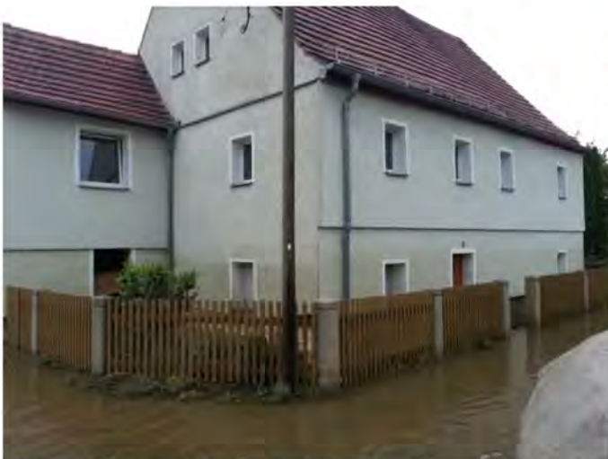
Abb. 1. Wohnhaus fünf Tage nach dem Höchstwasserstand 2013 (8,76m Elbepegel Dresden)
