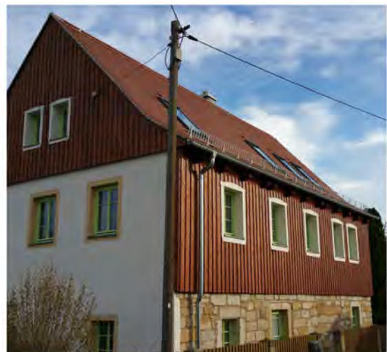
Abb. 2. Wohnhaus nach Sanierung 2016.
