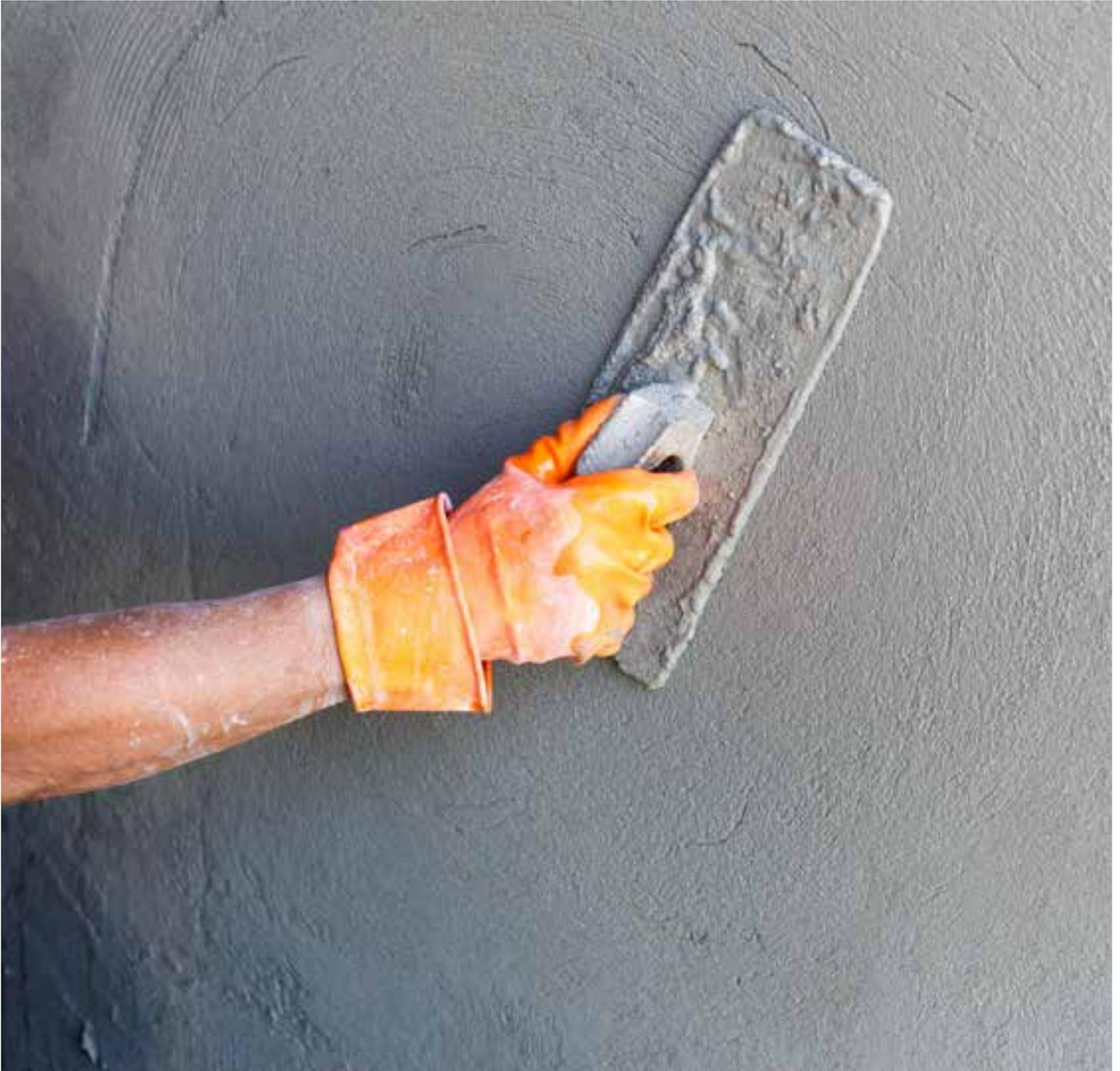
Der Außenputz dient der Fassadengestaltung und dem Feuchteschutz, ganz wichtig auch beim Sockel eines Hauses und der Kelleraußenwand. Manche Außenputze verbessern noch einmal den Wärmeschutz. Innenputze leisten einen wesentlichen Beitrag zur Luftdichtheit der Gebäudehülle.
